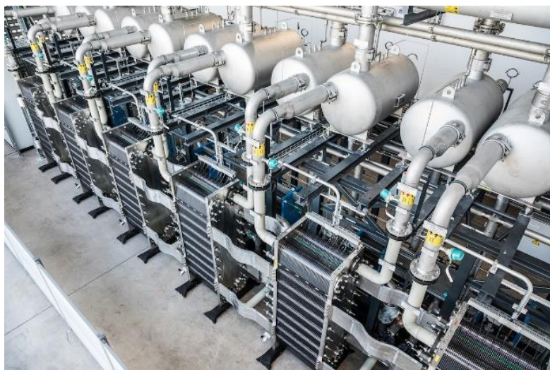
Obr. 38 - Uspořádání elektrolyzérů Silyzer 300
