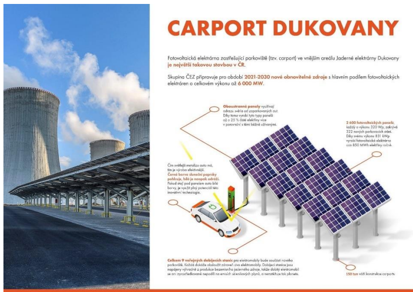
Obr. 70 - Carport v areálu JE Dukovany [66]
