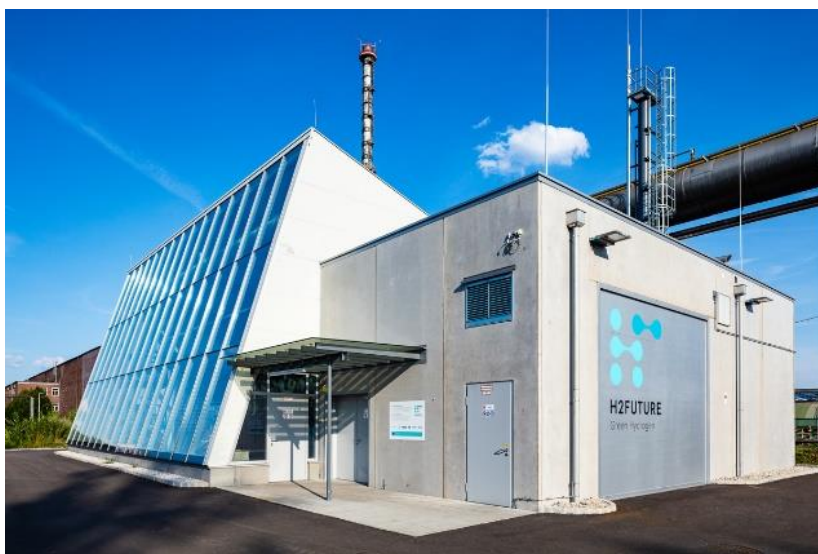
Obr. 39 - Budova s elektrolyzárem Silyzer 300 v rakouském Linci [29]
