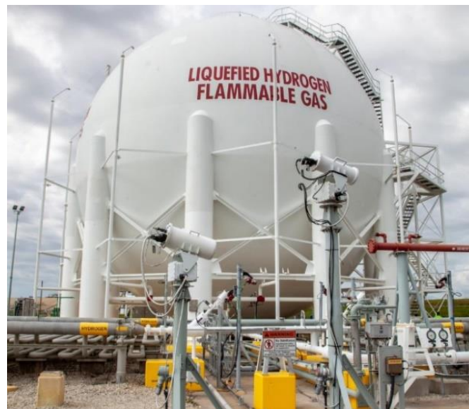
Obr. 44 - Velkoobjemový zásobník na kapalný vodík – 3 800 m 3 , 270 t (NASA)
